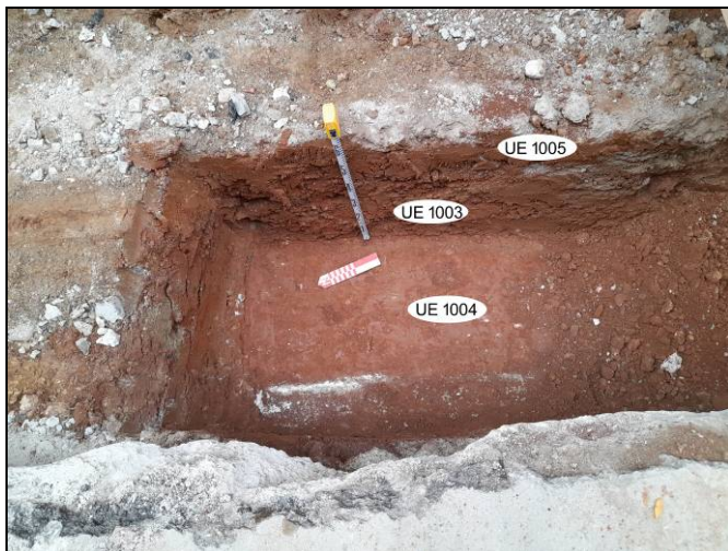
Foto 85. Tram Nogués-Sardenya. Enrasat dels nous embornals. Cala per embornal i estratigrafia.
