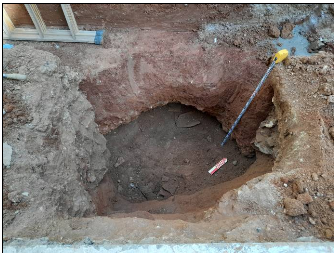
Foto 57. Tram Ventalló-Nogués. Rasa per a serveis i xarxa d'hidrants. Retall UE 1013.
