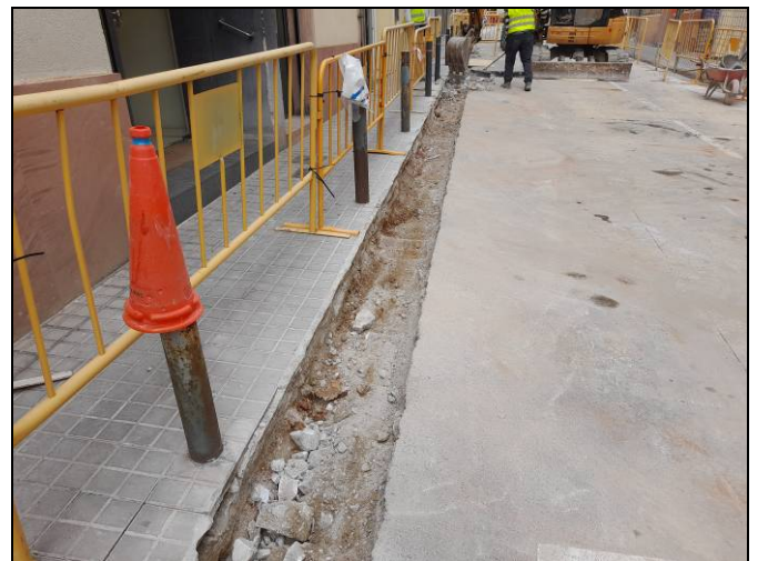
Foto 36. Tram Ventalló-Nogués. Rasa per a serveis i xarxa d'hidrants. Desmuntatge de la vorada.
