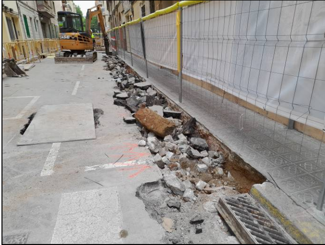
Foto 29. Tram Ventalló-Nogués. Enrasat dels nous embornals. Desmuntatge parcial de la calçada.
