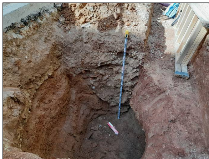
Foto 59. Tram Ventalló-Nogués. Rasa per a serveis i xarxa d'hidrants. Retall UE 1013.
