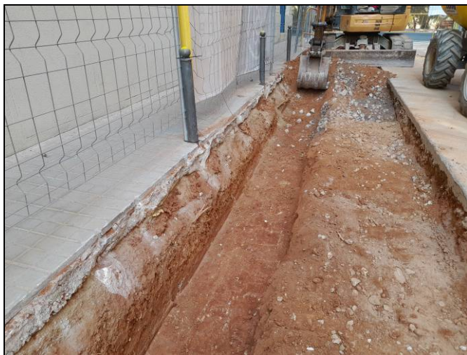
Foto 101. Tram Nogués-Sardenya. Rasa per a serveis i xarxa d'hidrants. Obertura de la rasa per a serveis.
