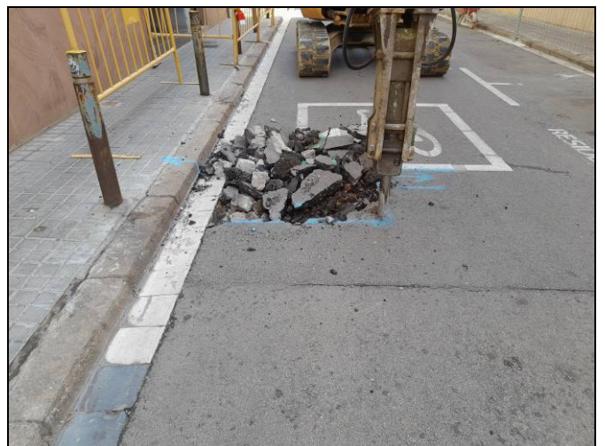
Foto 8. Tram Ventalló-Nogués. Obertura d'una cala per escocell.
