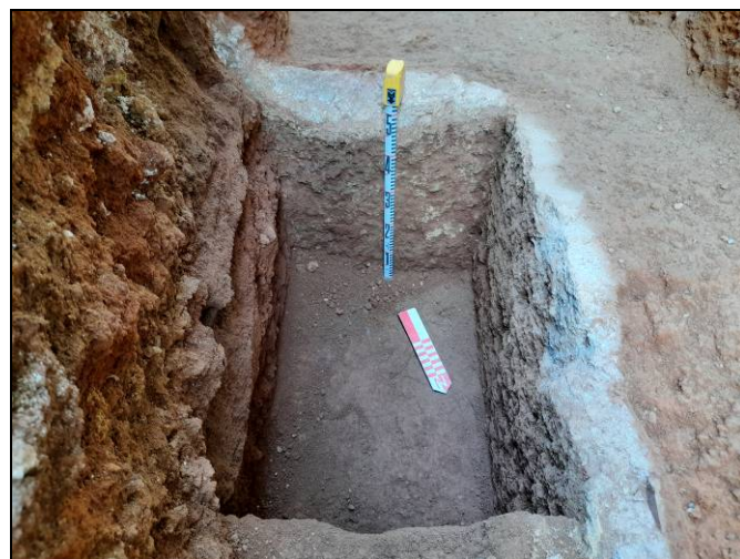
Foto 56. Tram Ventalló-Nogués. Rasa per a serveis i xarxa d'hidrants. Dipòsit UE 1010.
