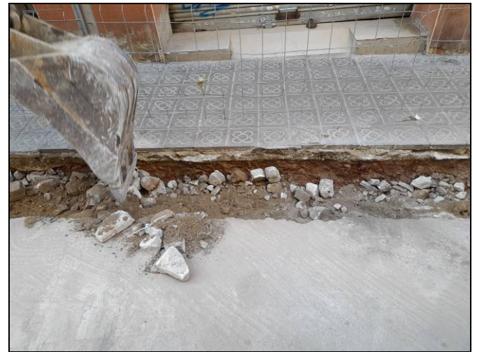
Foto 28. Tram Ventalló-Nogués. Enrasat dels nous embornals. Desmuntatge de la vorada.
