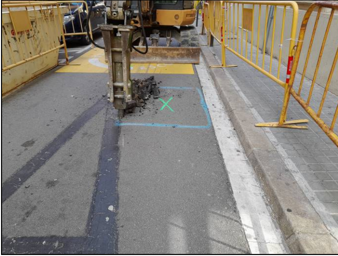
Foto 69. Tram Nogués-Sardenya. Obertura d'una cala per escocell.
