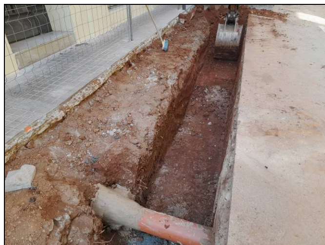
Foto 95. Tram Nogués-Sardenya. Rasa per a serveis i xarxa d'hidrants. Obertura de la rasa per la xarxa d'hidrants.
