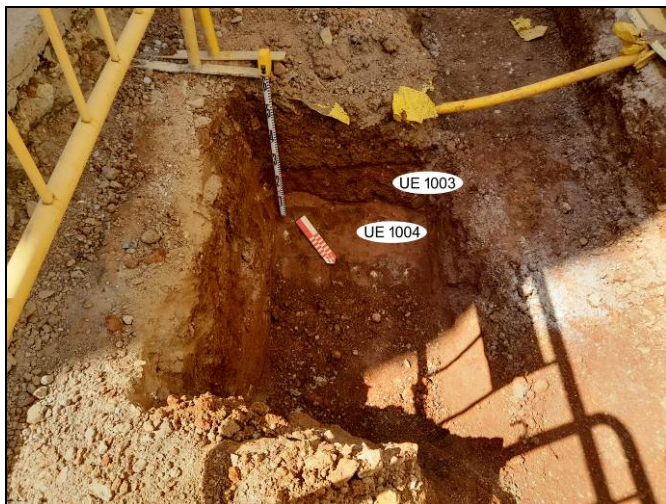
Foto 45. Tram Ventalló-Nogués. Rasa per a serveis i xarxa d'hidrants. Cala per a fanal.
