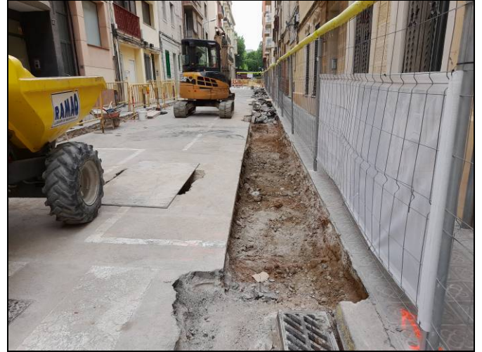
Foto 30. Tram Ventalló-Nogués. Enrasat dels nous embornals. Desmuntatge parcial de la calçada.
