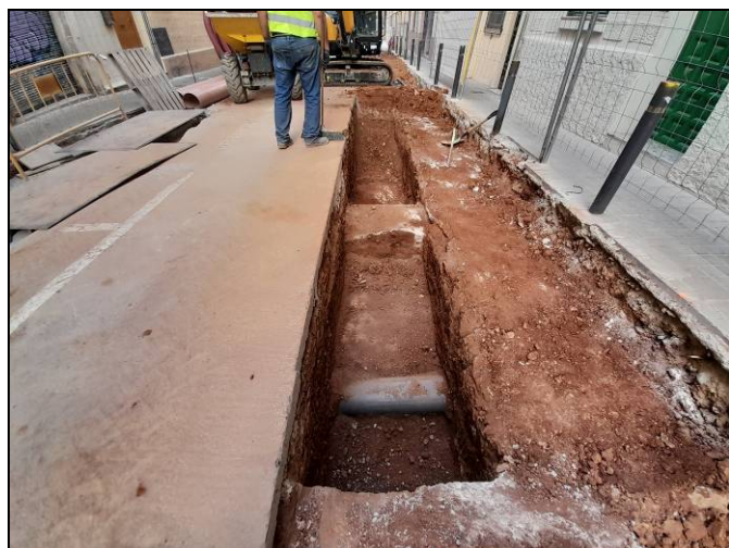
Foto 47. Tram Ventalló-Nogués. Rasa per a serveis i xarxa d'hidrants. Obertura de la rasa per la xarxa d'hidrants.
