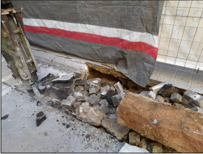
Foto 77. Tram Nogués-Sardenya. Enrasat dels nous embornals. Desmuntatge parcial de la calçada.
