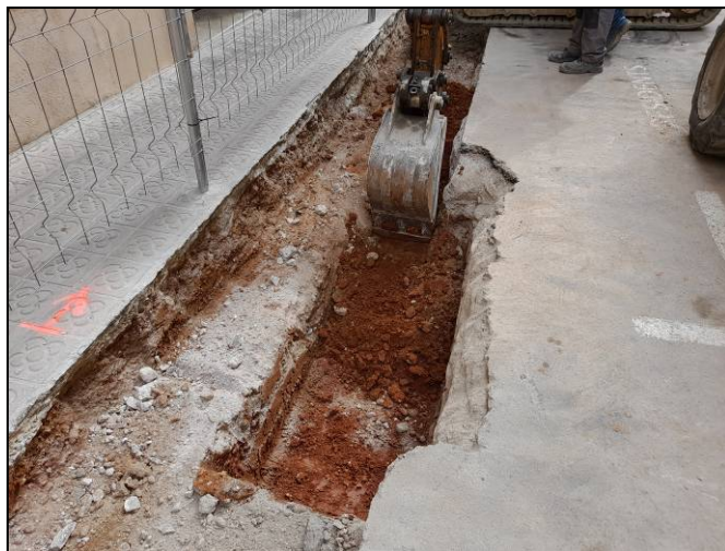
Foto 31. Tram Ventalló-Nogués. Enrasat dels nous embornals. Rebaix de la rasa.
