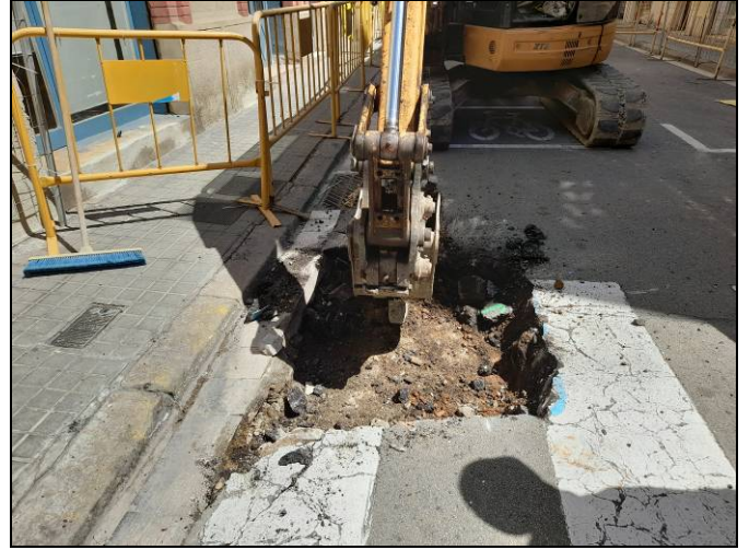
Foto 62. Tram Nogués-Sardenya. Obertura d'una cala per escocell.
