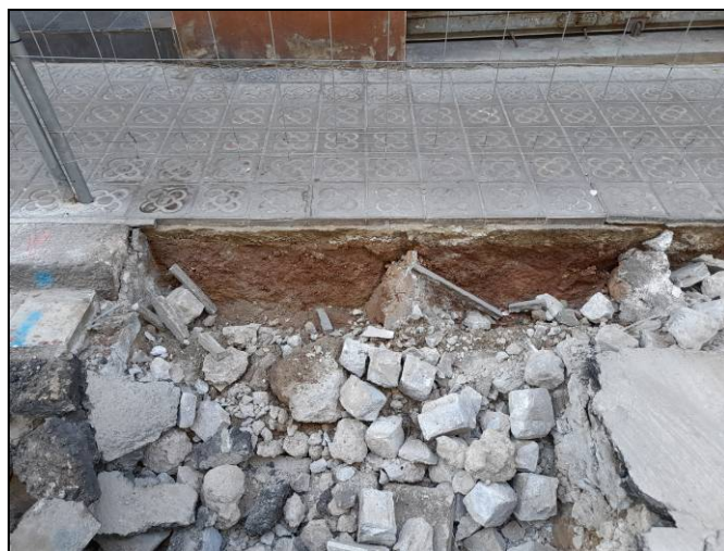
Foto 76. Tram Nogués-Sardenya. Enrasat dels nous embornals. Desmuntatge de la vorada.
