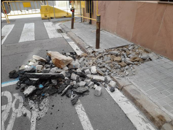
Foto 9. Tram Ventalló-Nogués. Obertura d'una cala per escocell.
