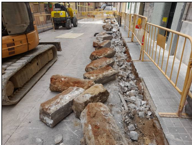
Foto 35. Tram Ventalló-Nogués. Rasa per a serveis i xarxa d'hidrants. Desmuntatge de la vorada.
