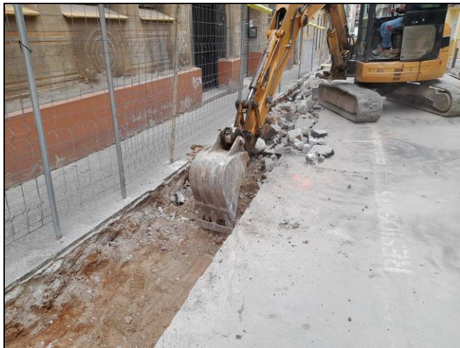
Foto 81. Tram Nogués-Sardenya. Enrasat dels nous embornals. Desmuntatge parcial de la calçada.
