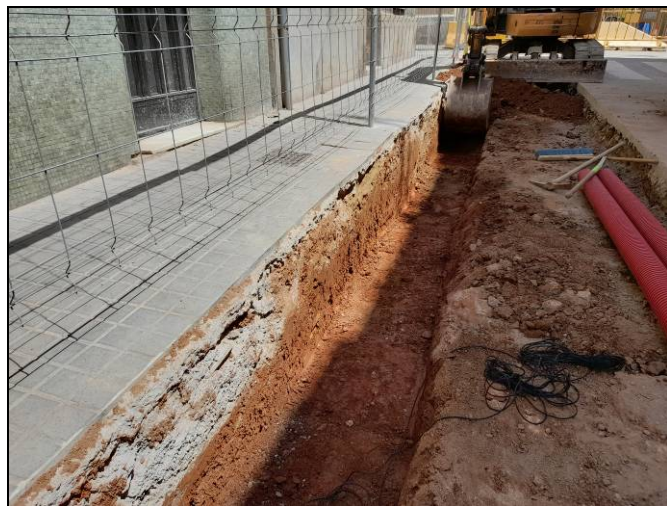
Foto 42. Tram Ventalló-Nogués. Rasa per a serveis i xarxa d'hidrants. Obertura de la rasa per a serveis.
