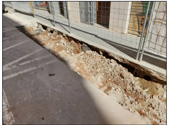
Foto 80. Tram Nogués-Sardenya. Enrasat dels nous embornals. Desmuntatge parcial de la calçada.
