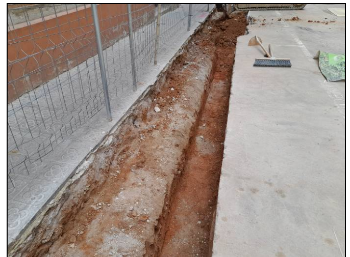
Foto 32. Tram Ventalló-Nogués. Enrasat dels nous embornals. Rebaix de la rasa.
