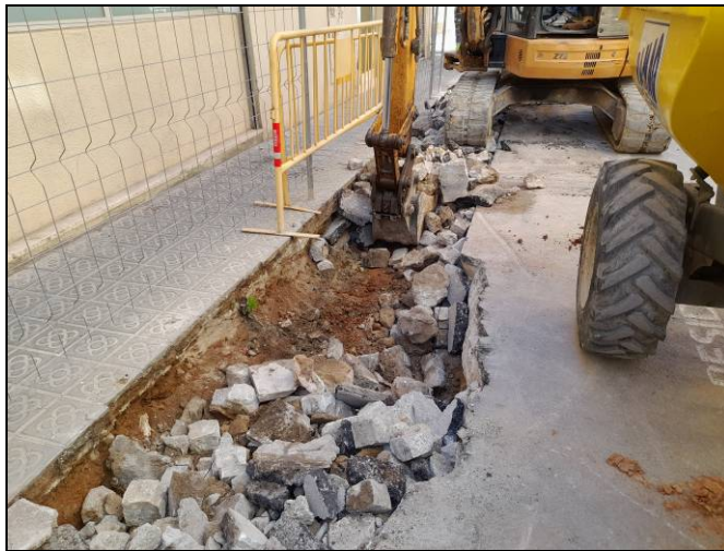
Foto 79. Tram Nogués-Sardenya. Enrasat dels nous embornals. Desmuntatge parcial de la calçada.
