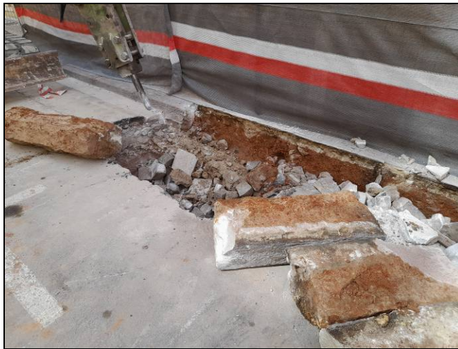
Foto 27. Tram Ventalló-Nogués. Enrasat dels nous embornals. Desmuntatge de la vorada.
