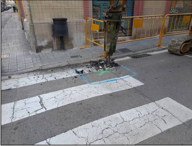
Foto 61. Tram Nogués-Sardenya. Obertura d'una cala per escocell.
