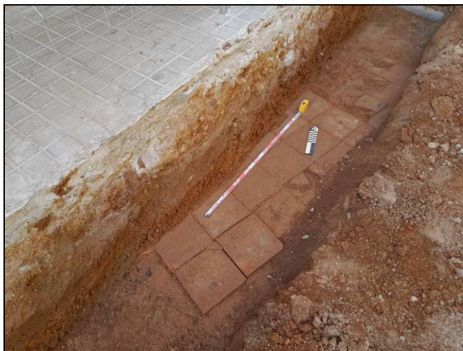
Foto 49. Tram Ventalló-Nogués. Rasa per a serveis i xarxa d'hidrants. Paviment UE 1008.
