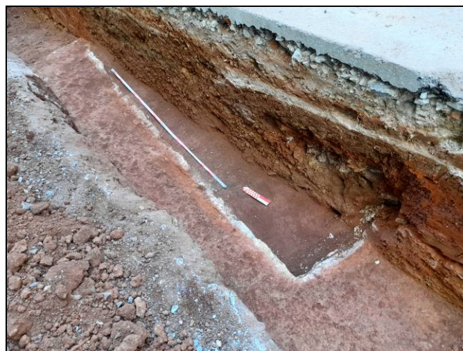
Foto 51. Tram Ventalló-Nogués. Rasa per a serveis i xarxa d'hidrants. Dipòsit UE 1010.
