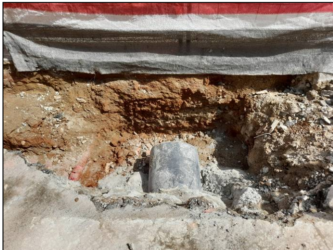
Foto 89. Tram Nogués-Sardenya. Enrasat dels nous embornals. Cala per embornal sobre un de ja existent.
