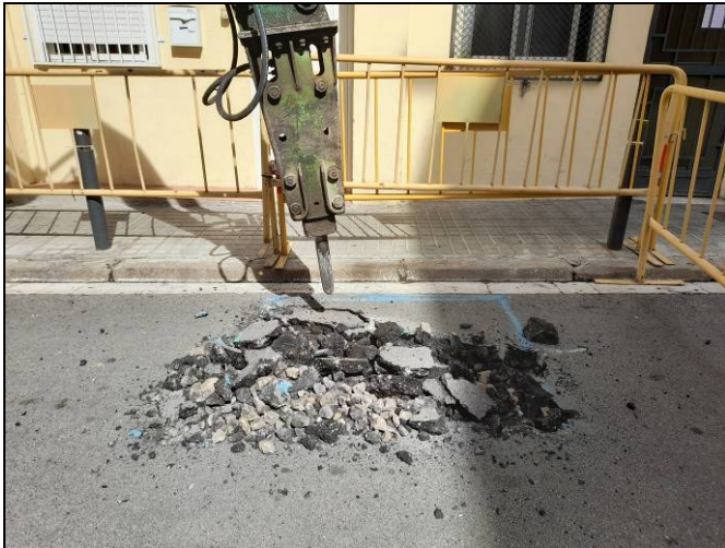
Foto 13. Tram Ventalló-Nogués. Obertura d'una cala per escocell.
