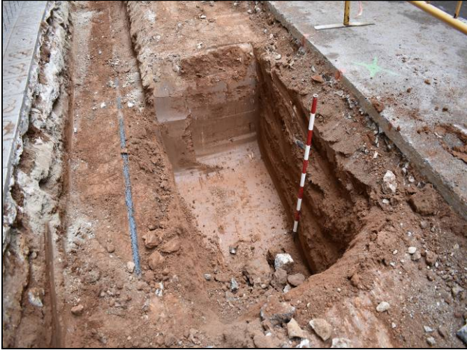
Foto 105. Tram Hipòlit Lázaro-Pau Alsina. Obertura d'una cala per escocell.
