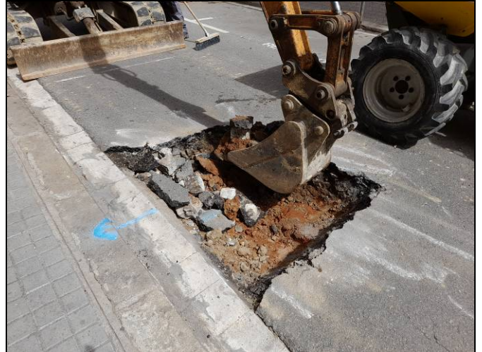
Foto 14. Tram Ventalló-Nogués. Obertura d'una cala per escocell.
