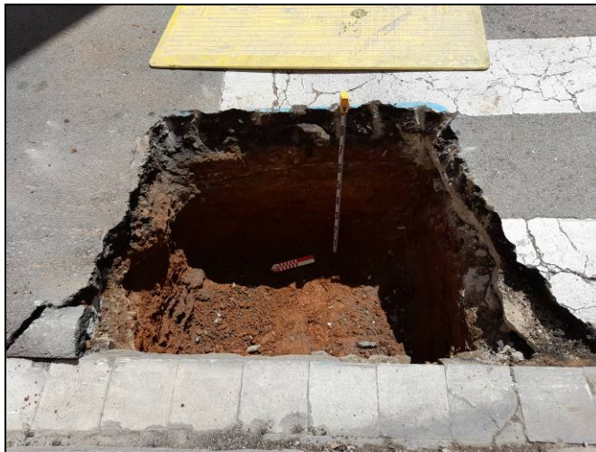
Foto 63. Tram Nogués-Sardenya. Obertura d'una cala per escocell.
