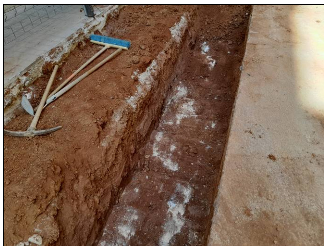
Foto 99. Tram Nogués-Sardenya. Rasa per a serveis i xarxa d'hidrants. Obertura de la rasa per la xarxa d'hidrants. Litificacions calcàries naturals.
