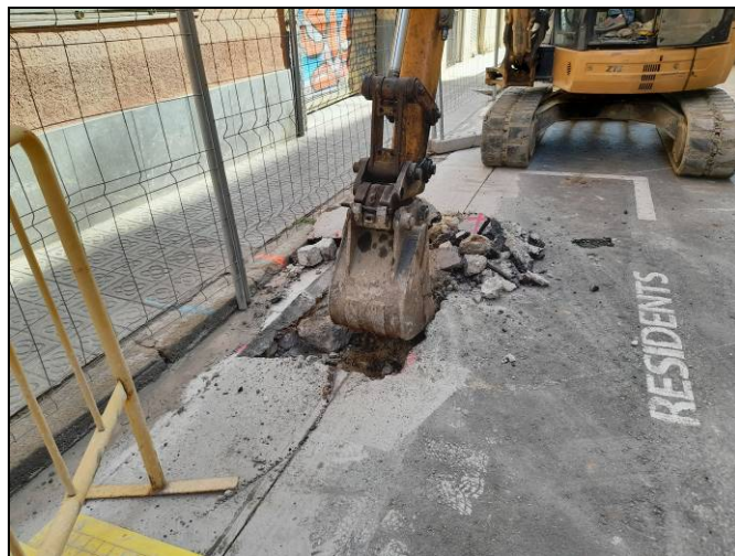
Foto 74. Tram Nogués-Sardenya. Obertura d'una cala per escocell.
