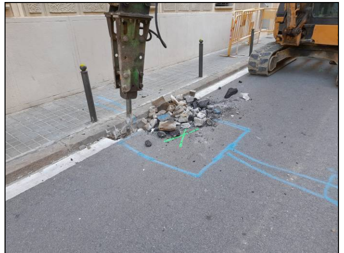
Foto 64. Tram Nogués-Sardenya. Obertura d'una cala per escocell.
