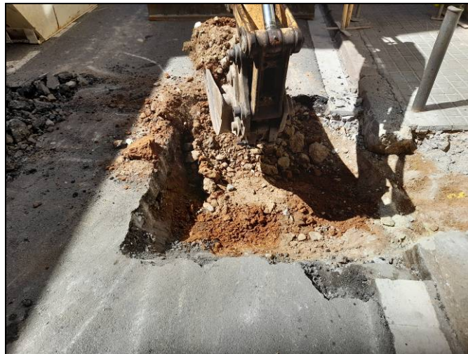
Foto 66. Tram Nogués-Sardenya. Obertura d'una cala per escocell.
