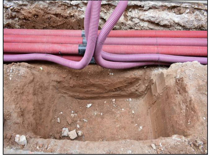
Foto 106. Tram Hipòlit Lázaro-Pau Alsina. Obertura d'una cala per escocell.
