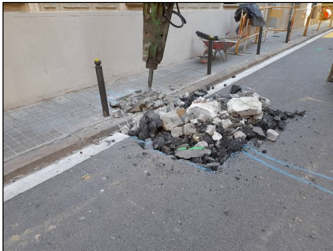
Foto 65. Tram Nogués-Sardenya. Obertura d'una cala per escocell.
