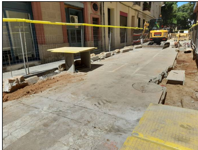
Foto 90. Tram Nogués-Sardenya. Rasa per a serveis i xarxa d'hidrants. Desmuntatge de la vorada.
