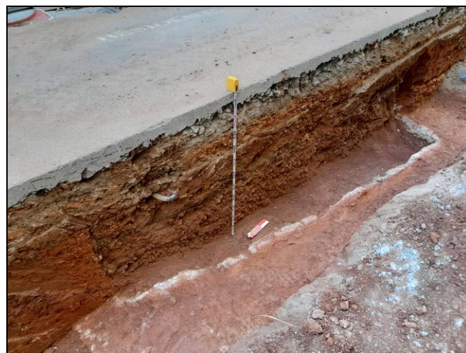
Foto 52. Tram Ventalló-Nogués. Rasa per a serveis i xarxa d'hidrants. Dipòsit UE 1010.
