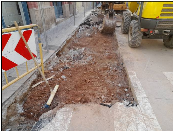
Foto 93. Tram Nogués-Sardenya. Rasa per a serveis i xarxa d'hidrants. Desmuntatge parcial de la calçada.
