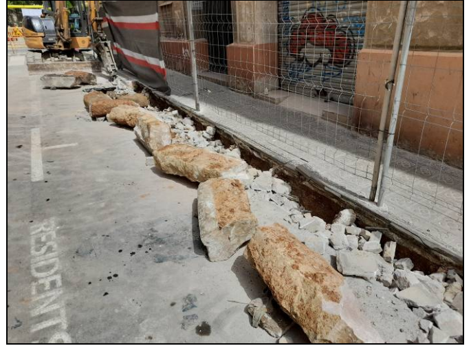
Foto 26. Tram Ventalló-Nogués. Enrasat dels nous embornals. Desmuntatge de la vorada.
