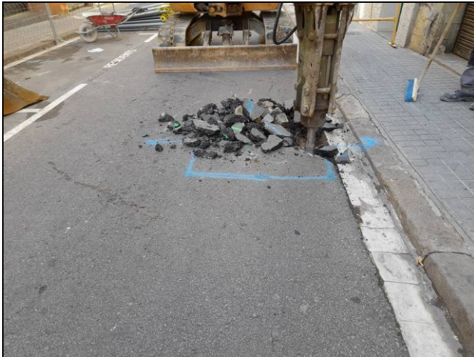
Foto 5. Tram Ventalló-Nogués. Obertura d'una cala per escocell.
