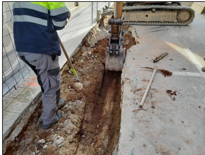
Foto 82. Tram Nogués-Sardenya. Enrasat dels nous embornals. Rebaix de la rasa.
