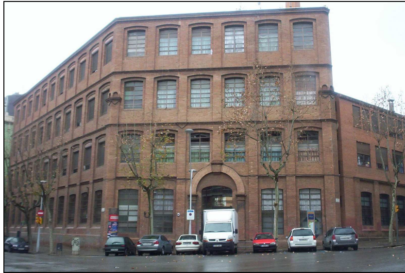
Figura 7. Antiga fàbrica Pujol i Casacoberta, actual IES La Sedeta (Autor).
