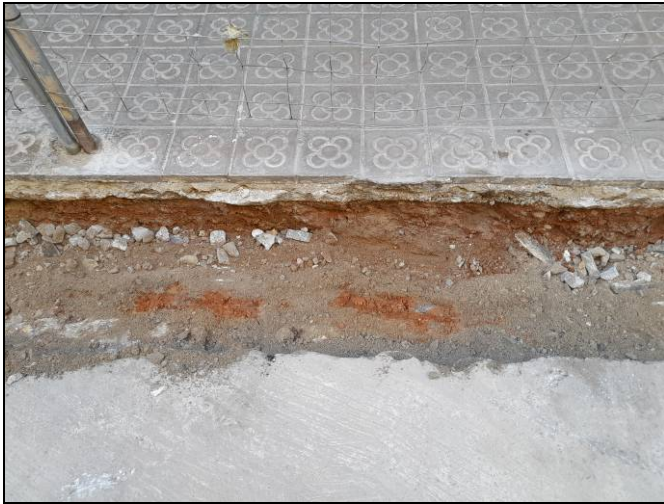
Foto 37. Tram Ventalló-Nogués. Rasa per a serveis i xarxa d'hidrants. Desmuntatge de la vorada.
