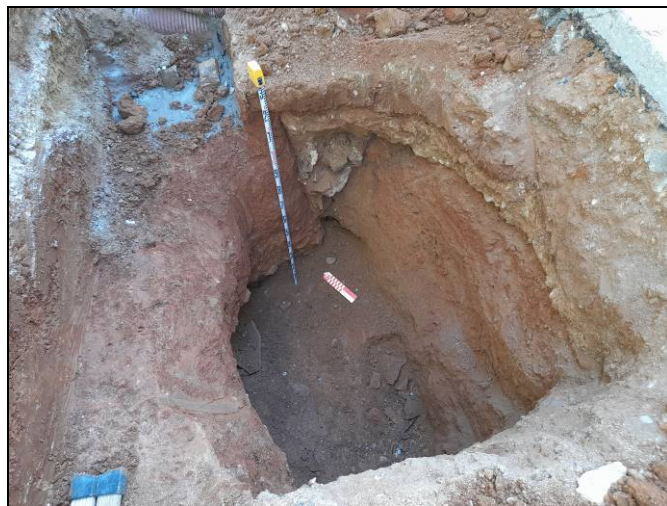
Foto 58. Tram Ventalló-Nogués. Rasa per a serveis i xarxa d'hidrants. Retall UE 1013.
