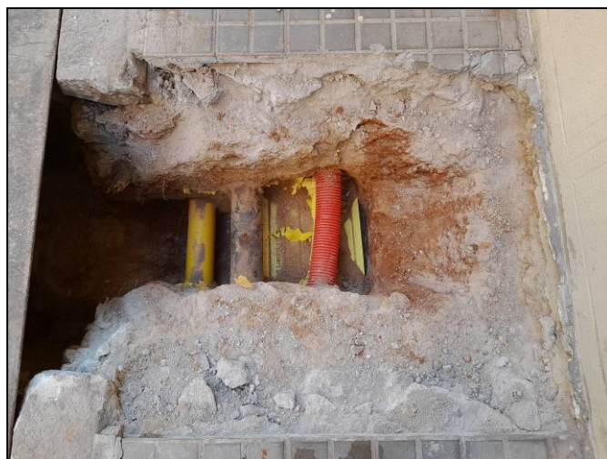
Foto 68. Tram Nogués-Sardenya. Obertura d'una cala per escocell. Serveis existents sota la vorera.
