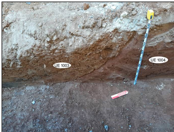
Foto 97. Tram Nogués-Sardenya. Rasa per a serveis i xarxa d'hidrants. Obertura de la rasa per la xarxa d'hidrants. Estratigrafia.
