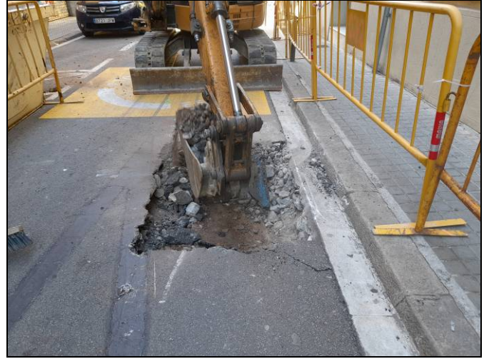
Foto 70. Tram Nogués-Sardenya. Obertura d'una cala per escocell.
