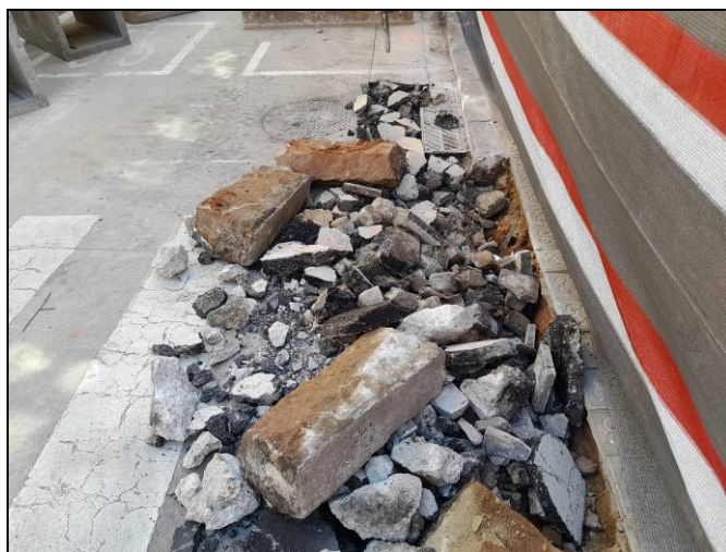
Foto 75. Tram Nogués-Sardenya. Enrasat dels nous embornals. Desmuntatge de la vorada.
