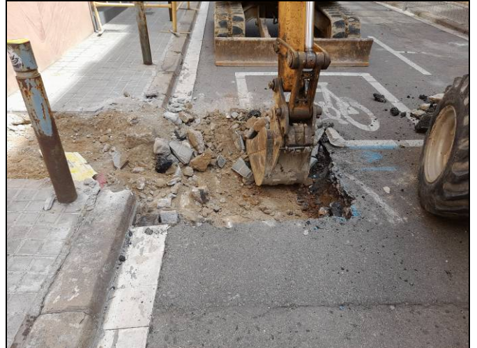
Foto 10. Tram Ventalló-Nogués. Obertura d'una cala per escocell.
