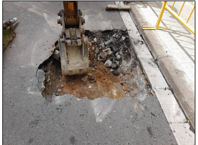
Foto 6. Tram Ventalló-Nogués. Obertura d'una cala per escocell.
