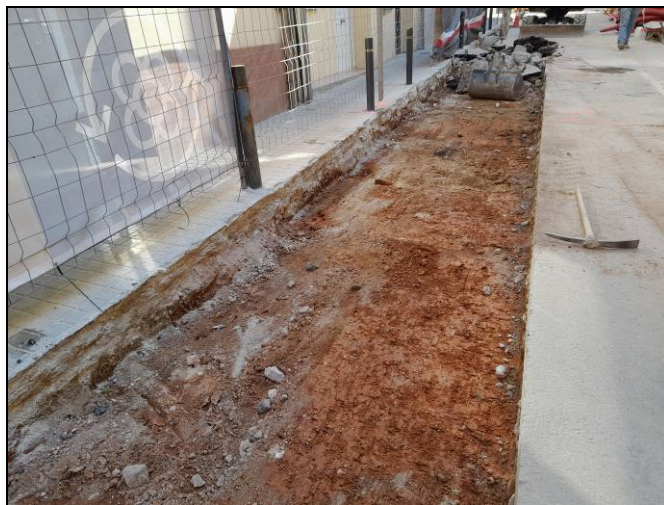
Foto 39. Tram Ventalló-Nogués. Rasa per a serveis i xarxa d'hidrants. Desmuntatge parcial de la calçada.
