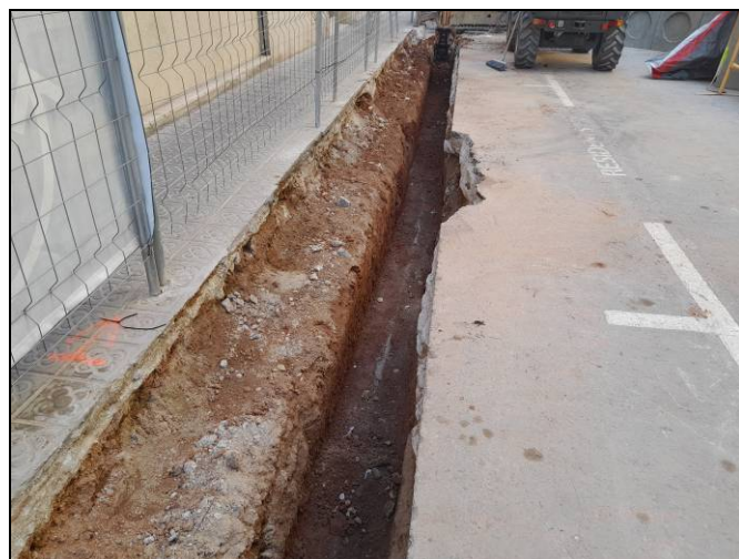
Foto 83. Tram Nogués-Sardenya. Enrasat dels nous embornals. Rebaix de la rasa.
