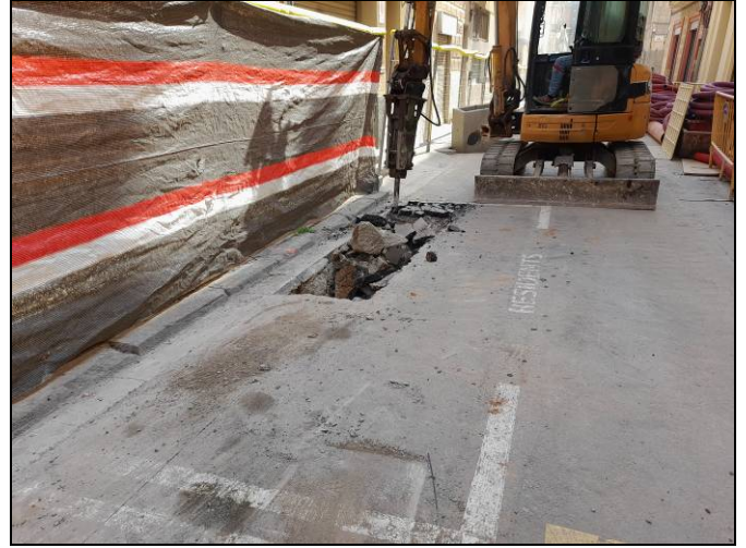
Foto 78. Tram Nogués-Sardenya. Enrasat dels nous embornals. Desmuntatge parcial de la calçada.
