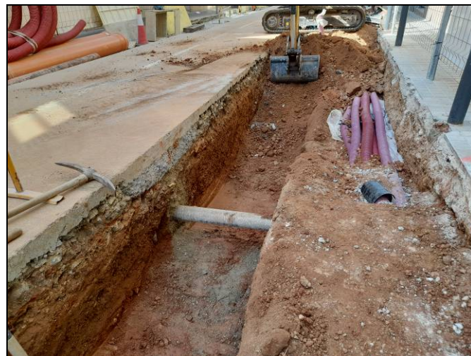
Foto 46. Tram Ventalló-Nogués. Rasa per a serveis i xarxa d'hidrants. Obertura de la rasa per la xarxa d'hidrants.
